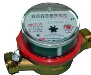
б) Счётчик воды крыльчатый OBCG-15
